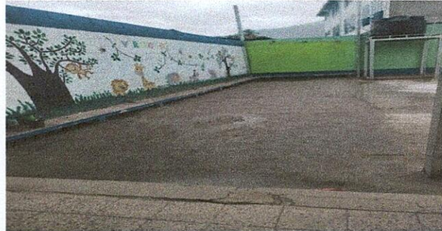
Foto 2: mejoramiento de losa de patio
