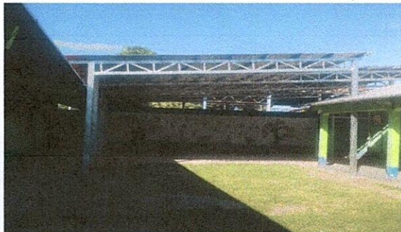
Foto1: mejoramiento de estructura y cubierta de patio
